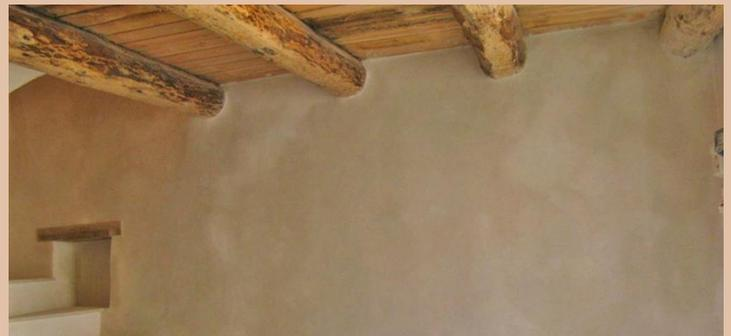
La zeolite vulcanica naturale micronizzata trasforma l'intonaco in una sorta di filtro in grado di facilitare l'equilibrio igrometrico degli ambienti e del supporto (mattone)
