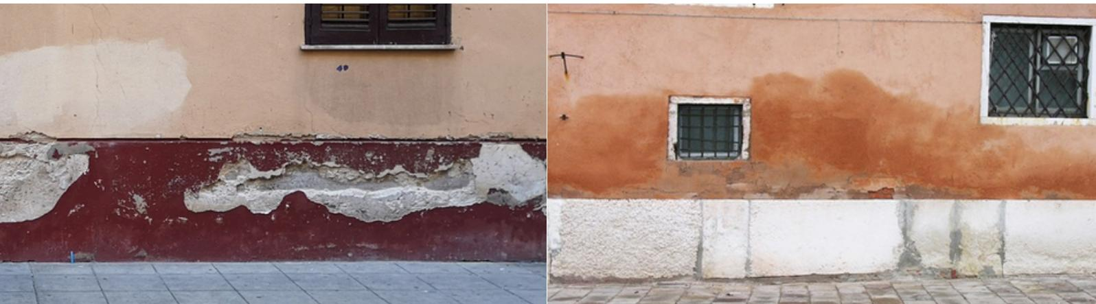
Il sistema più sicuro per eliminare la risalita capillare è la deumidificazione elettrofisica. Il metodo si basa sull'interruzione del processo fisico della capillarità secondo il quale le molecole dell'acqua risalgono dal terreno all'interno delle strutture murarie.
