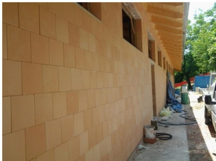
Blocco portante tamponamento realizzato con riempimento di granulato minerale e fibra di legno.
